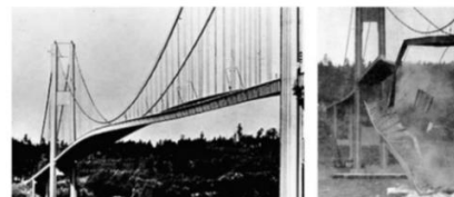
Gambar 2. Jembatan Tacoma I yang runtuh
