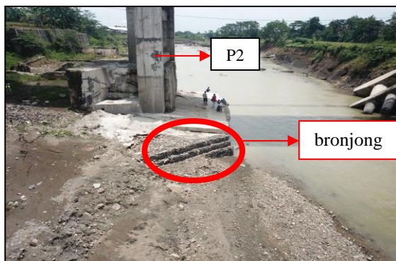
Gambar 22. Pemasangan bronjong pada jembatan Cipamingkis
