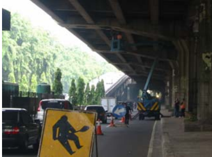
Gambar 12. Jembatan Layang P 172
