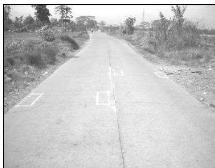
Lokasi survey di Jalan Damri, Ujungberung-Bandung lebar lajur 2 m
