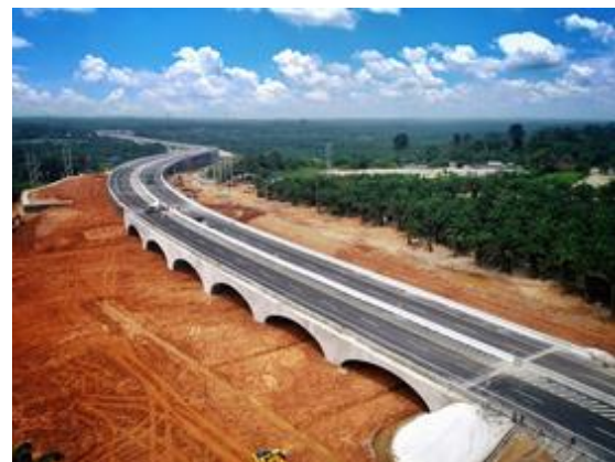
Gambar 3. Jembatan struktur baja bergelombang dan timbunan ringan jalan tol Pekanbaru-Dumai
