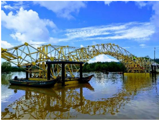
Gambar 3. Jembatan apung Cilacap (Pusjatan 2016)
