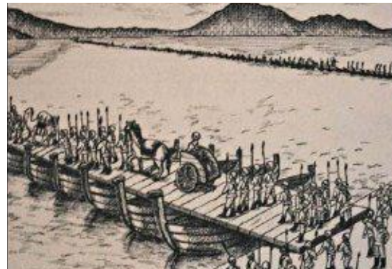
Gambar 1. Jembatan apung dari deretan perahu (Saleh 2010)
