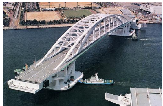
Gambar 2. Jembatan apung yang dapat diputar: Yumemai Bridge, Jepang (Maruyama 2008)
